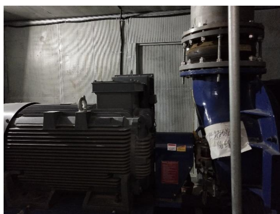
软管和软接头、减震基础
