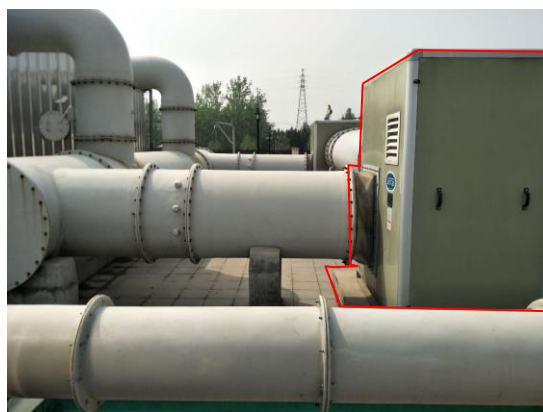
除臭系统风机隔声罩、软连接及减震基础
