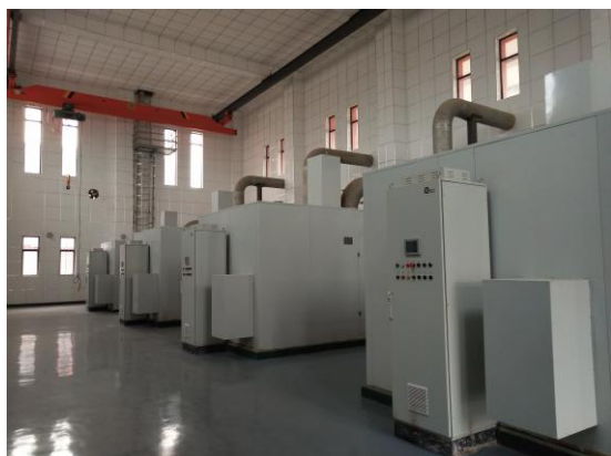
鼓风机房隔音罩及吸声墙面
