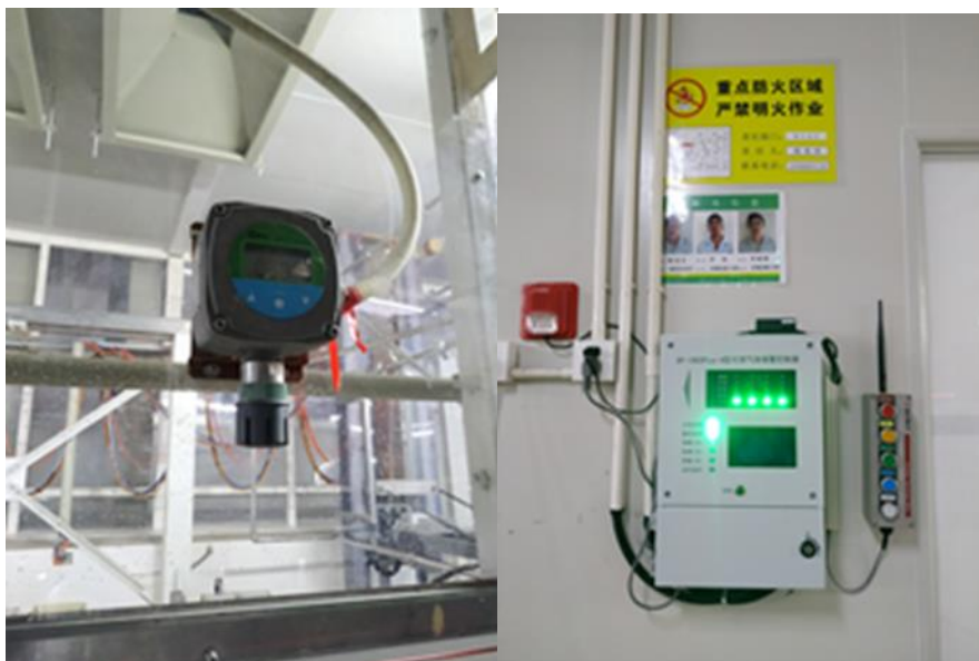
图 3 化学镍金生产线氰化氢报警系统
