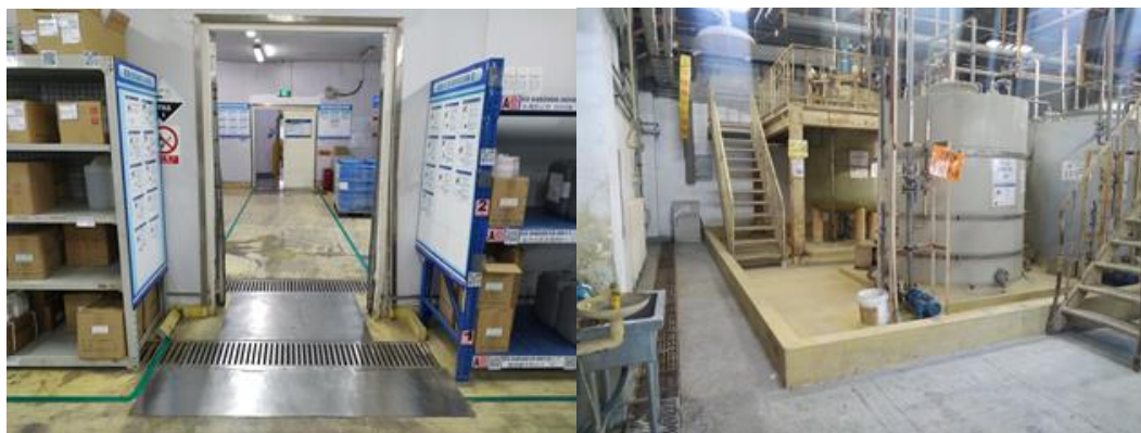
图 2 化学品库房围堰、应急池
