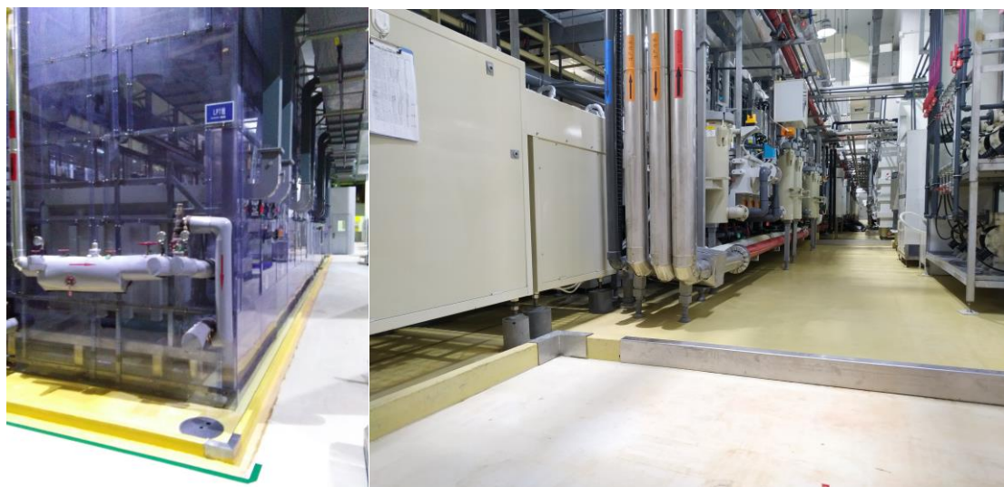
图 3-13 生产线围堰
