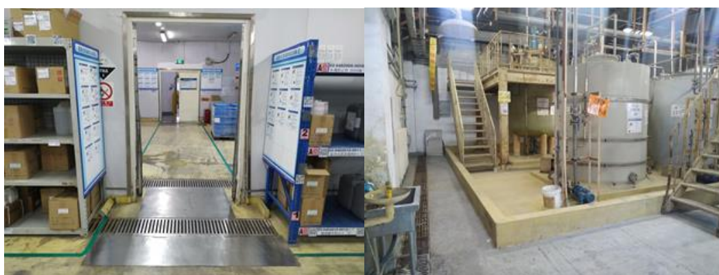
图 2 化学品库房围堰、应急池
