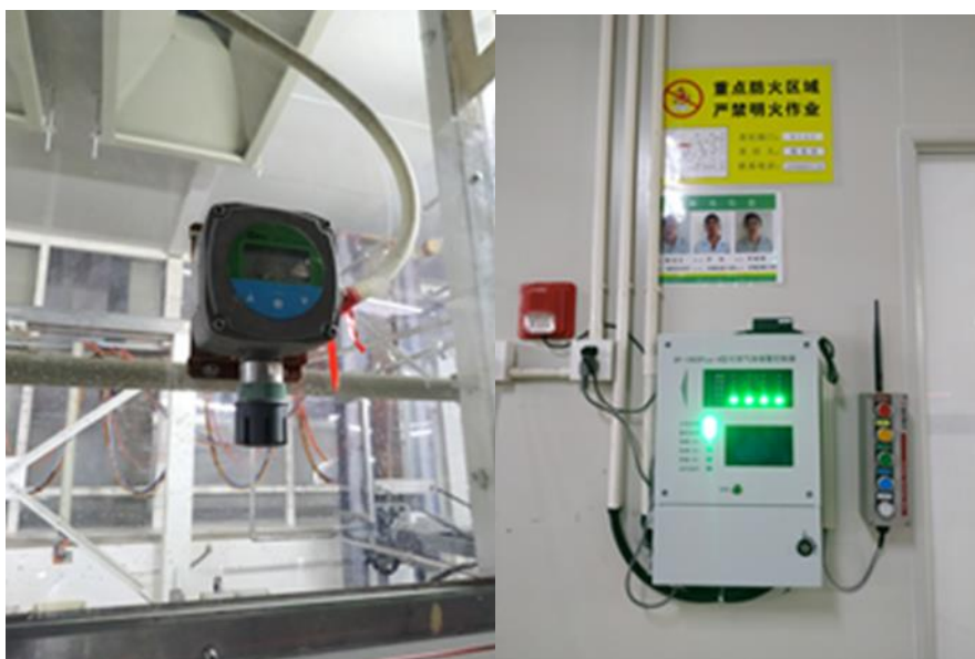
图 3 化学镍金生产线氰化氢报警系统
