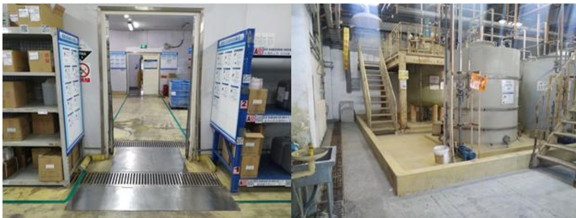
图 3-11 化学品库房围堰、应急池
