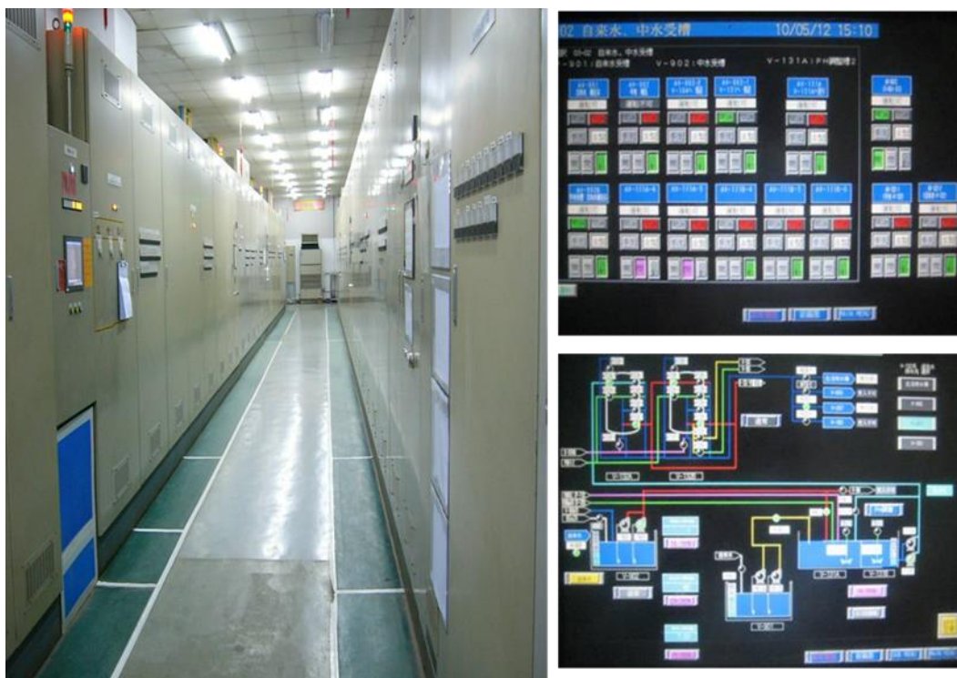
图 3-7 水处理中央控制室和在线设备控制室
