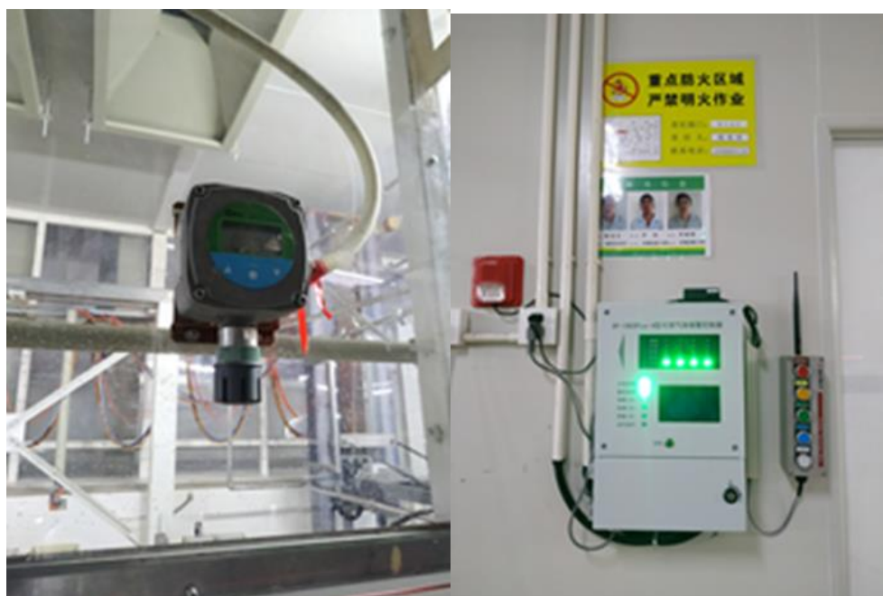
图 3-12 化学镍金生产线氰化氢报警系统
