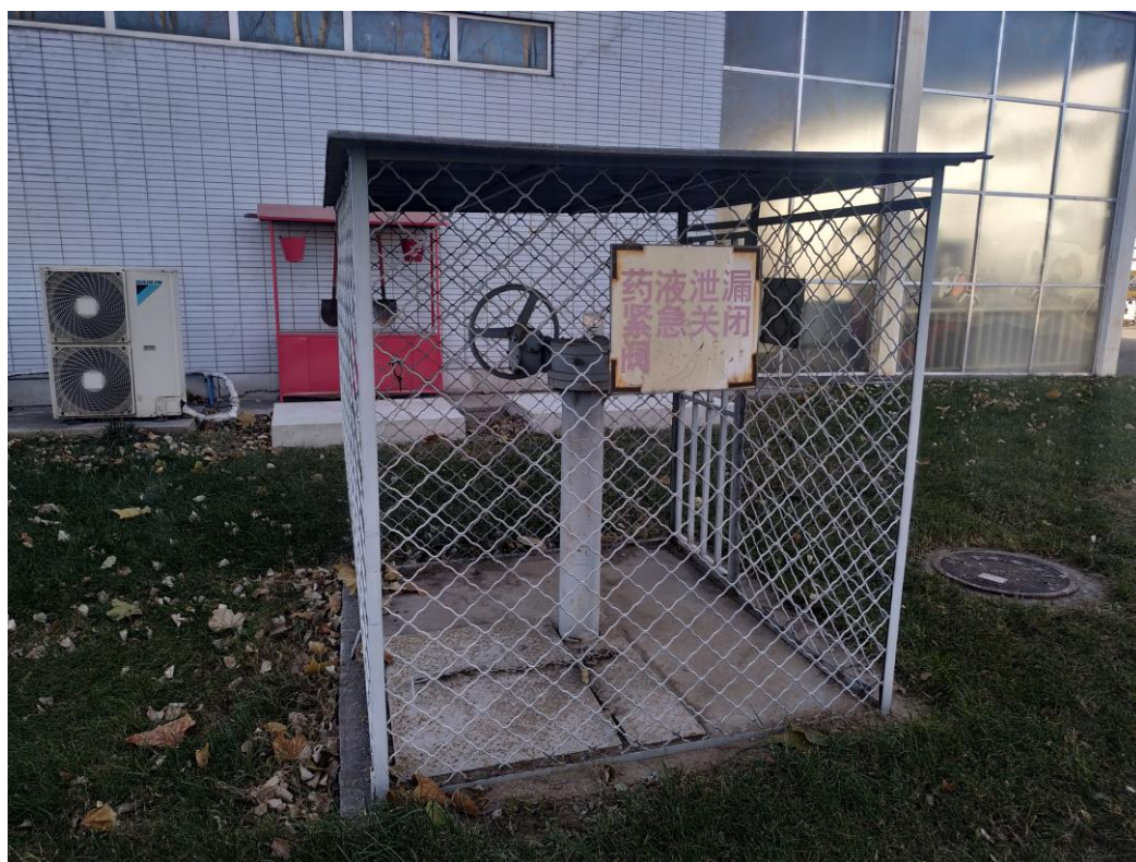
雨水紧急切断阀
