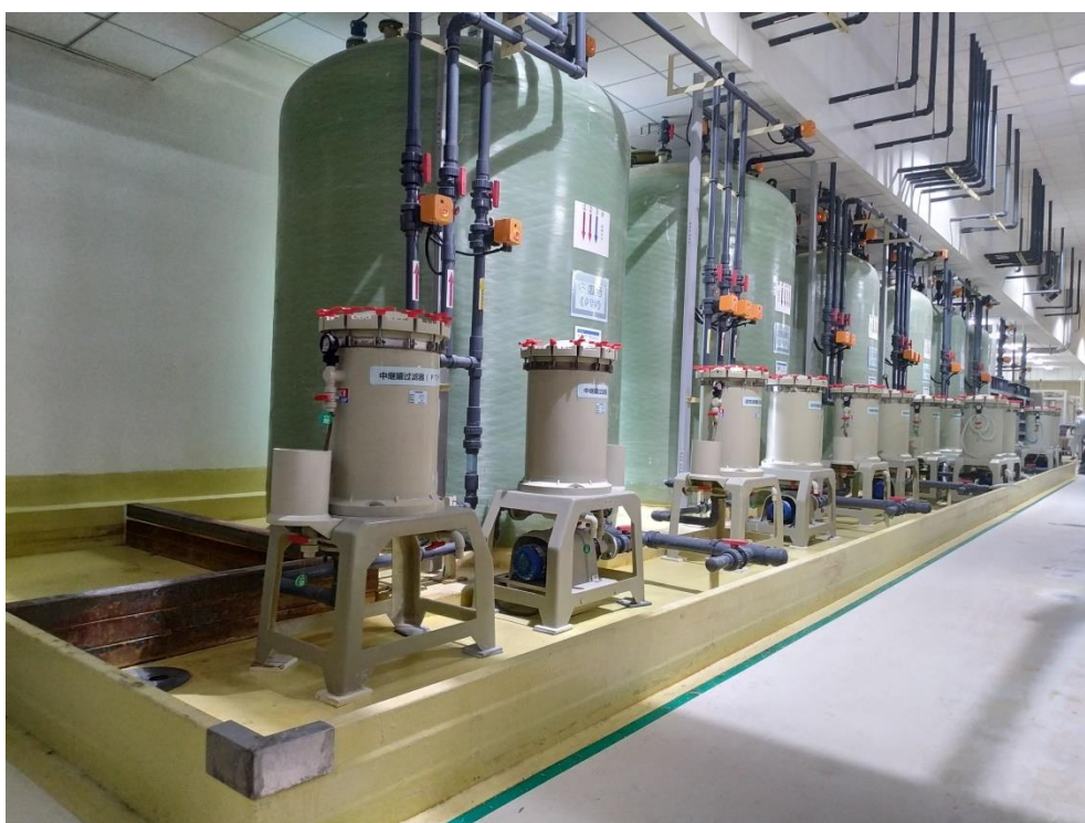
图 4-4 生产线药液罐防液堤（1）
