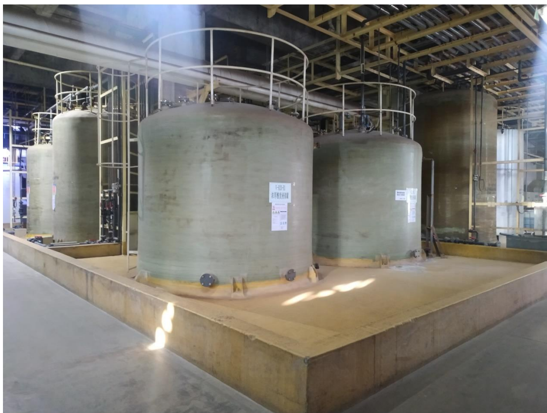
图 4-18 水处理废液罐区防液堤 (1)
