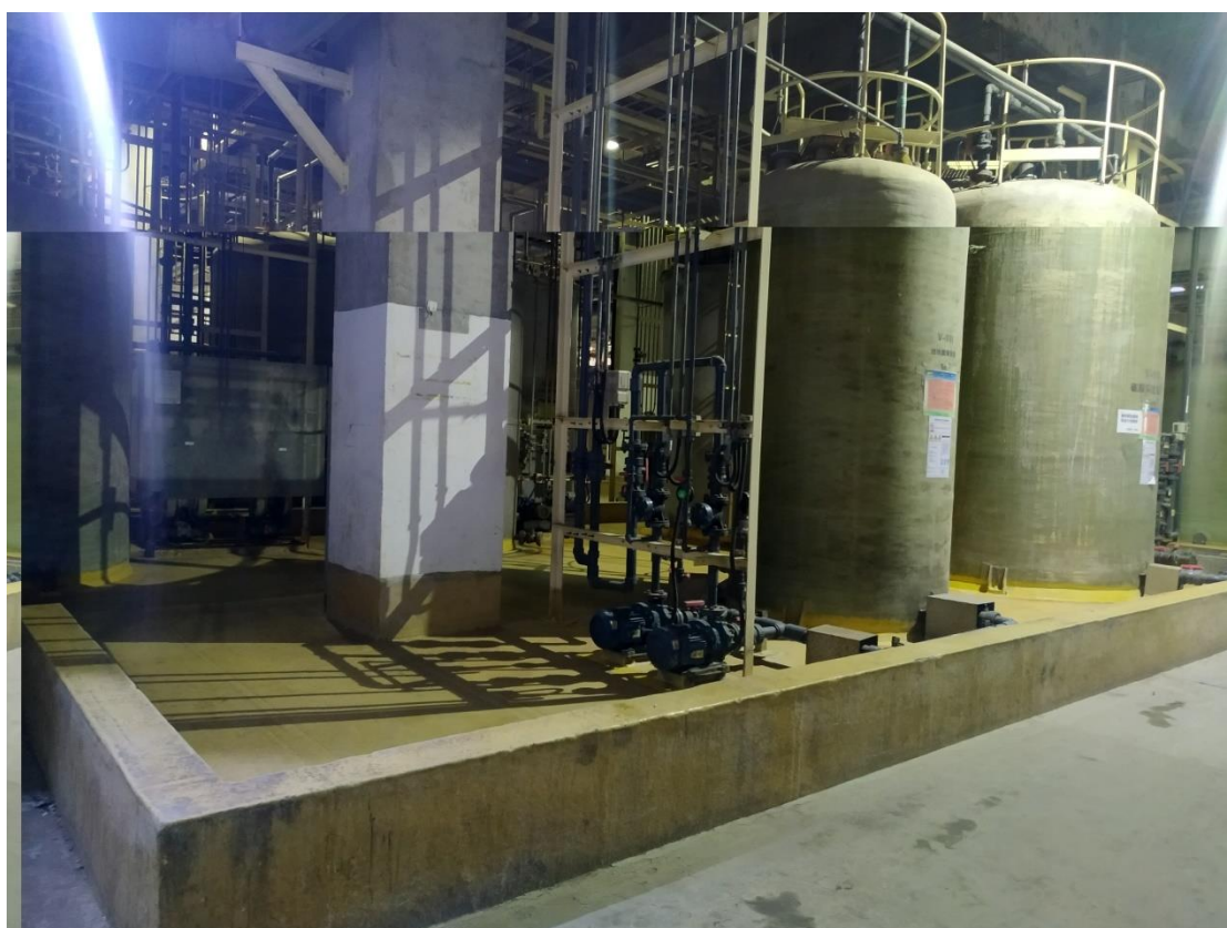
图 4-19 水处理废液罐区防液堤 (2)
