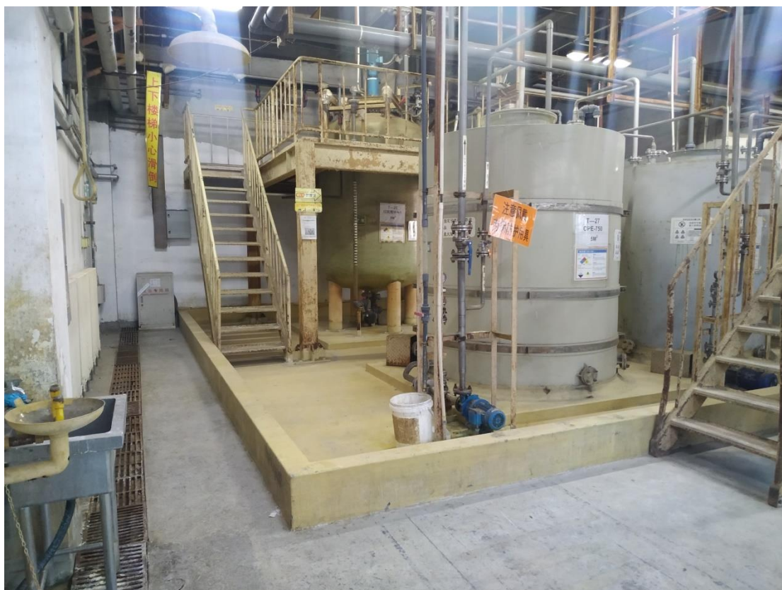
图 4-10 建浴化学品罐区防液堤（2）
