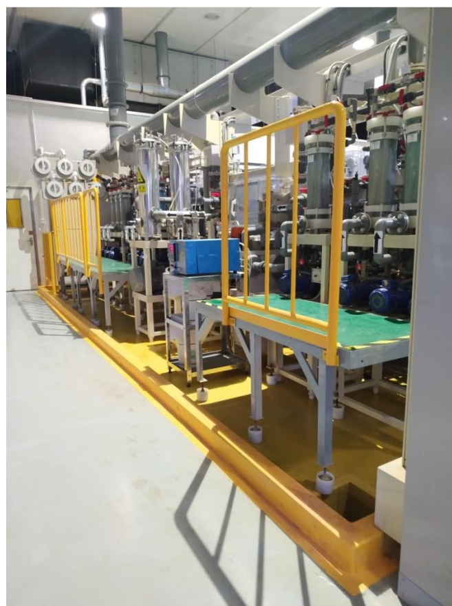
图 4-8 抗蚀膜防液堤
