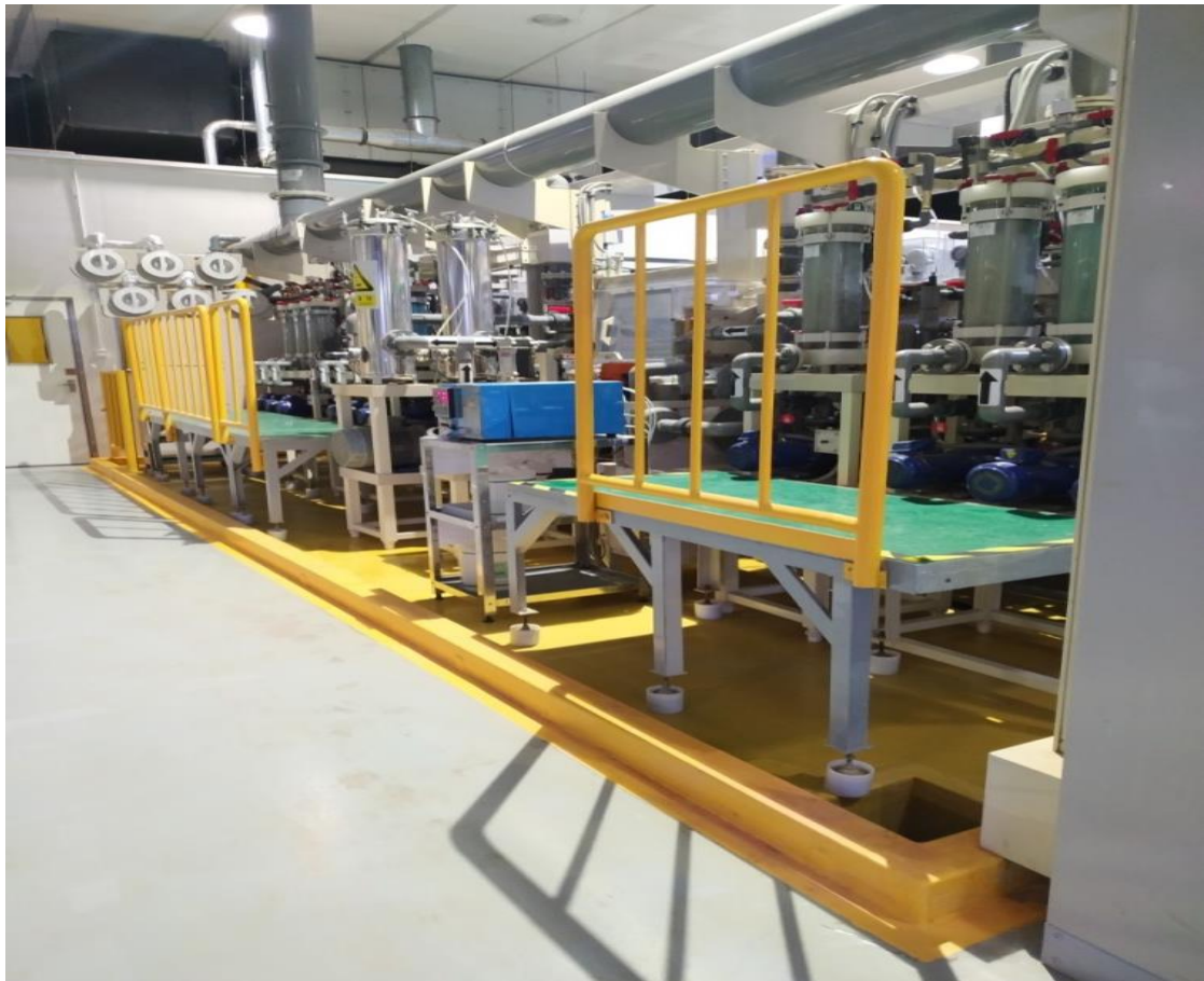
图 4-10 架空生产线及环氧树脂地面+围堰
