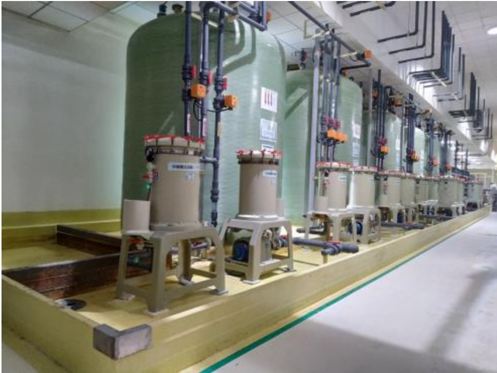
图 4-1 建浴化学品罐区及防渗措施
