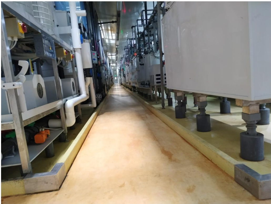
图 4-5 化学铜 2#3#防液堤
