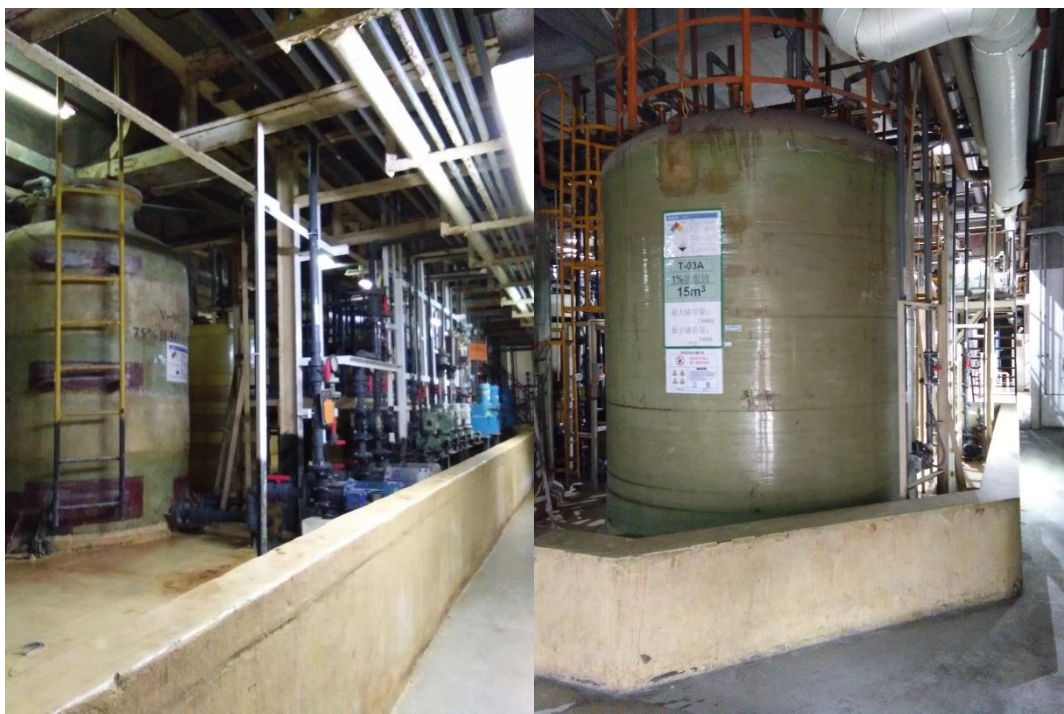
图 4-8 建浴化学品罐区防液堤
