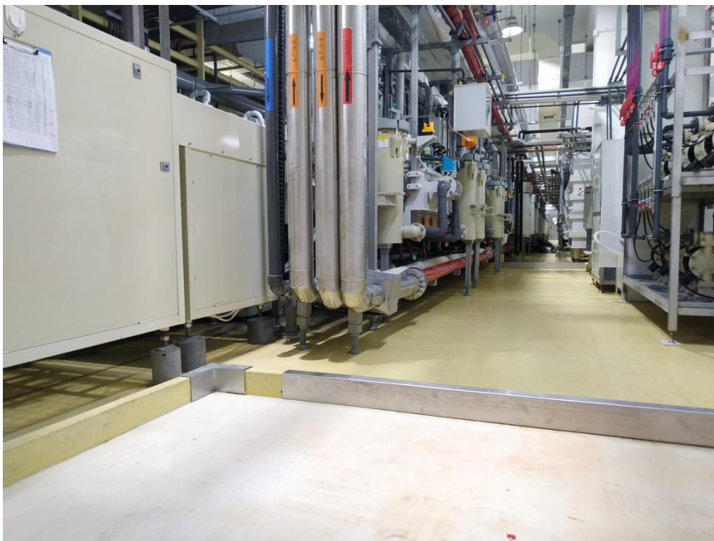
图 4-4 化学铜 3# 防液堤
