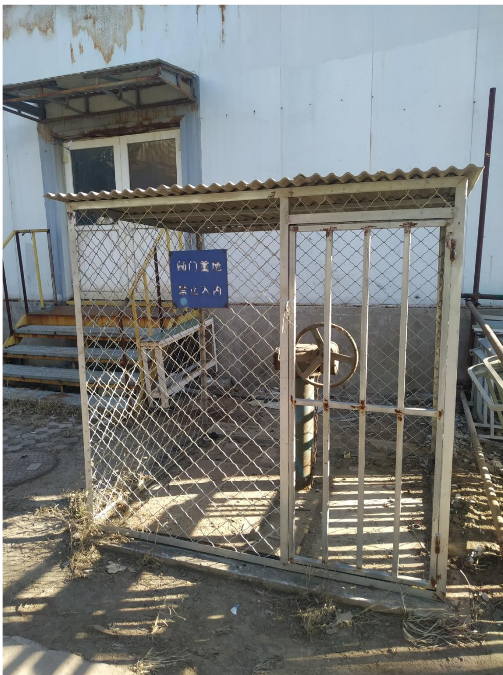
图 4-18 水处理应急切断阀
