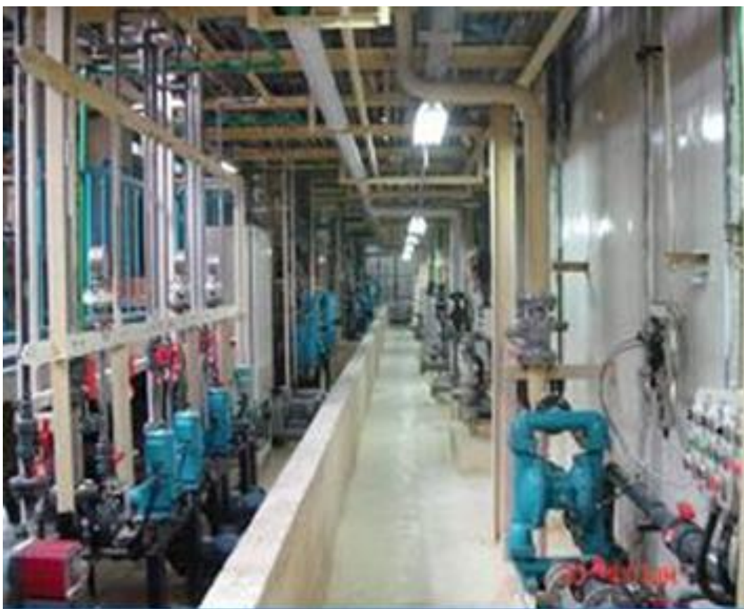
图 4-17 水处理现场处理设施+防液堤照片
